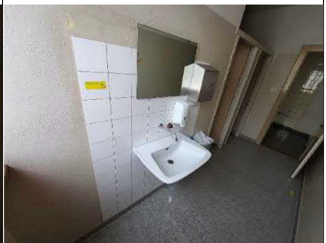
037-05 Standort: Erdgeschoss WC Damen
