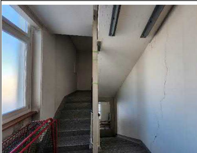
038-01 Standort: Erdgeschoss Treppenhaus
