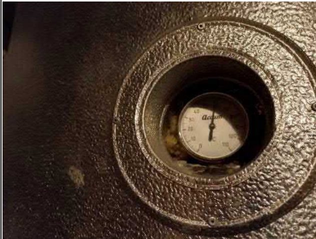
003-04 Standort: 1. Untergeschoss Putzmaterial
