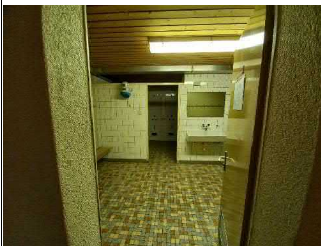
070-07 Standort: 1. Untergeschoss Umkleide-Raum Dusche
