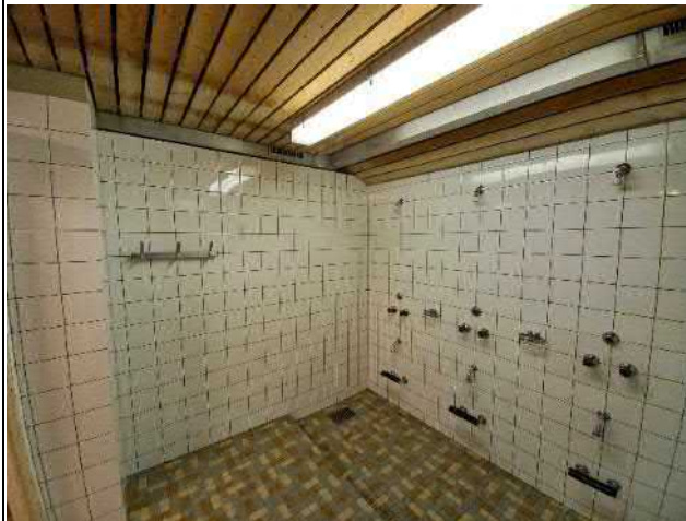
037-11 Standort: 1. Untergeschoss Umkleide-Raum Dusche
