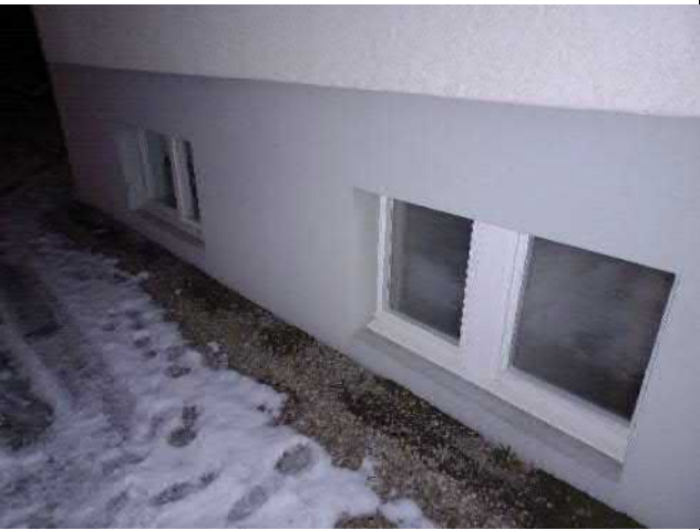
074-01 Standort: Erdgeschoss Aussenfassade
