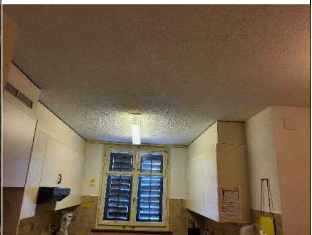
012-05 Standort: Dachgeschoss Raum 3 (Küche)
