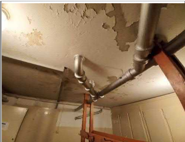
067-01 Standort: 1. Untergeschoss Turner-Garderobe
