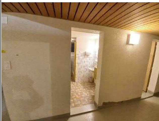
070-01 Standort: 1. Untergeschoss Einzel-Dusche 1
