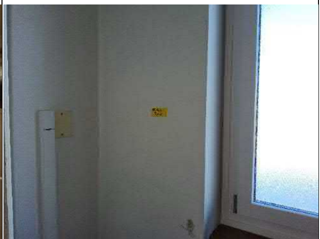
038-01 Standort: Erdgeschoss Treppenhaus
