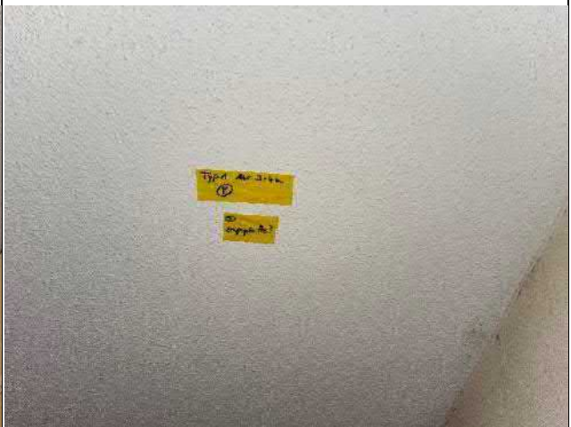
012-06 Standort: Dachgeschoss Treppenhaus
