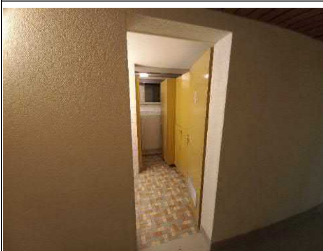
070-02 Standort: 1. Untergeschoss Einzel-Dusche 2
