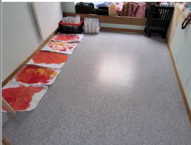
008-10 Standort: Dachgeschoss Raum 1
