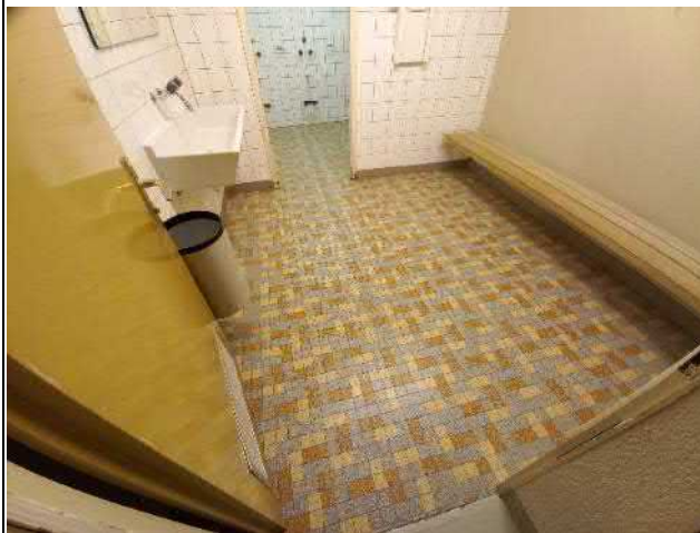
070-04 Standort: 1. Untergeschoss Umkleide-Raum Dusche
