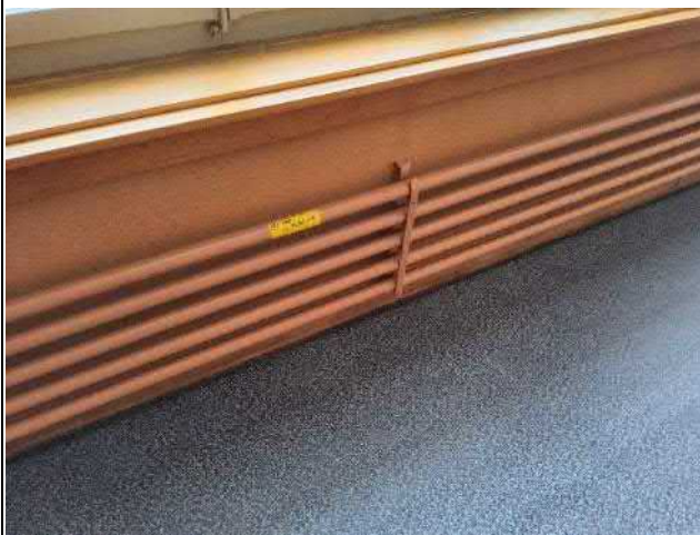
036-01 Standort: 1. Obergeschoss Galerie
