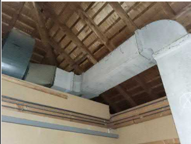
001-04 Standort: Dachgeschoss Estrich
