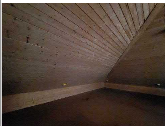
009-01 Standort: Dachgeschoss Estrich (Verdacht)
