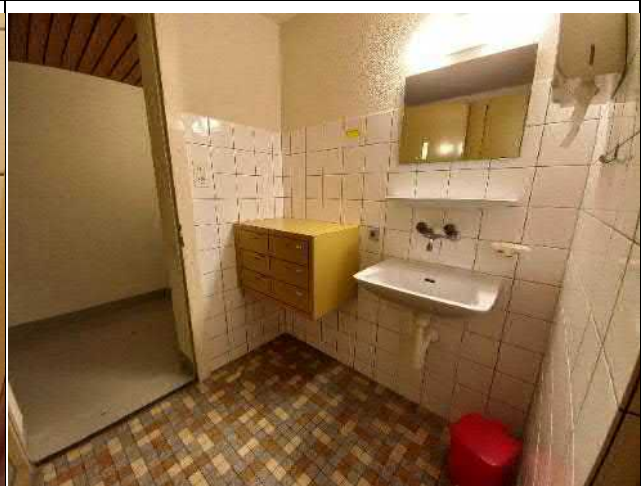
037-09 Standort: 1. Untergeschoss Einzel-Dusche 2
