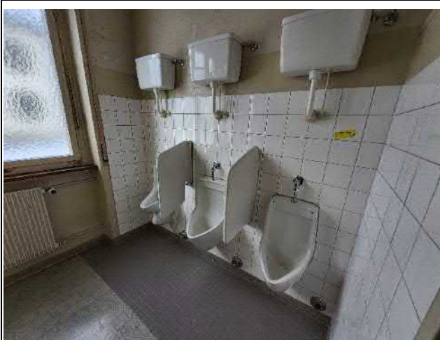
037-06 Standort: Erdgeschoss WC Herren
