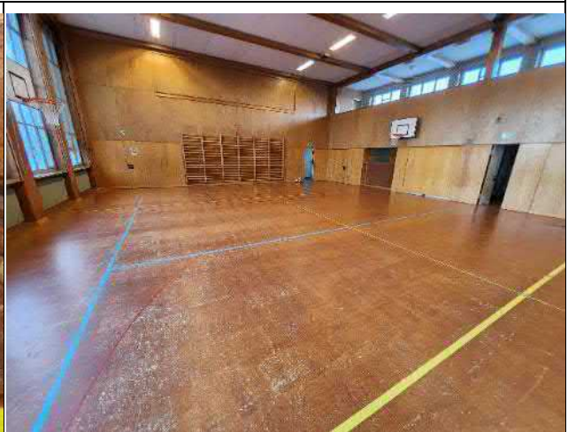
064-01 Standort: Erdgeschoss Turnhalle
