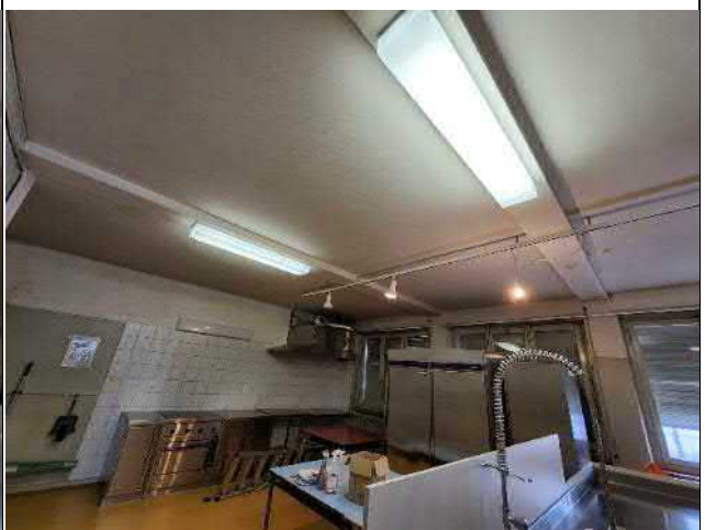
046-02 Standort: Erdgeschoss Küche
