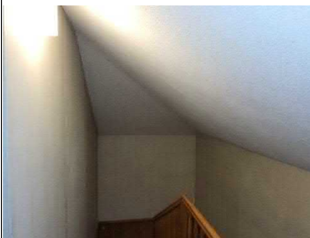
012-06 Standort: Dachgeschoss Treppenhaus
