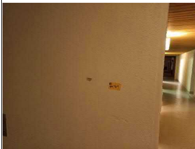
013-04 Standort: 1. Untergeschoss Korridor
