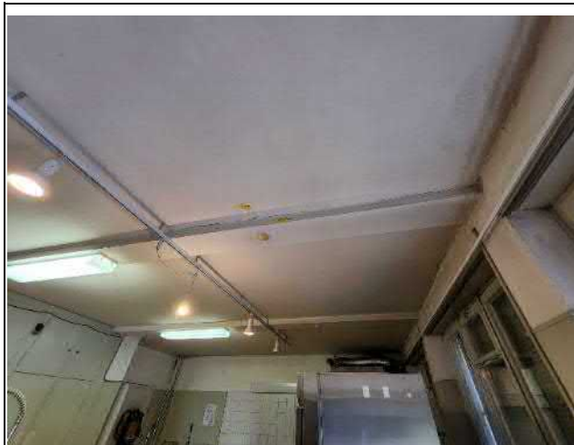
047-02 Standort: Erdgeschoss Küche
