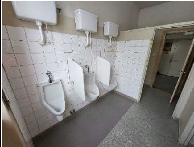
037-06 Standort: Erdgeschoss WC Herren
