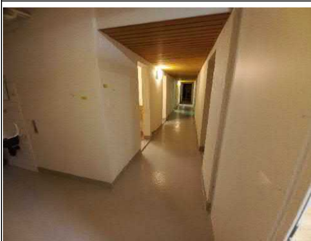
069-01 Standort: 1. Untergeschoss Korridor
