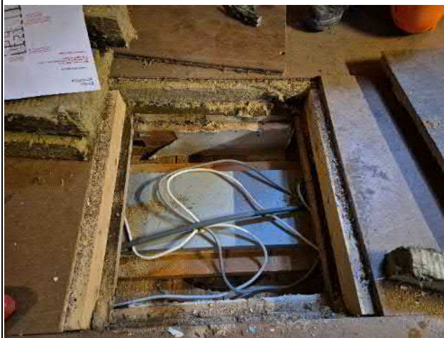
061-01 Standort: Erdgeschoss Turnhalle
