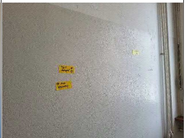
038-03 Standort: Erdgeschoss WC Damen
