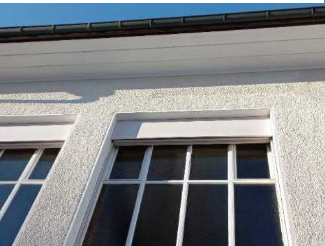
084-01 Standort: Erdgeschoss Aussenfassade
