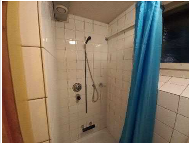
037-09 Standort: 1. Untergeschoss Einzel-Dusche 2
