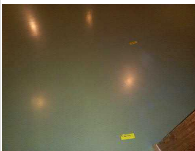
032-04 Standort: 1. Untergeschoss Laufbahn
