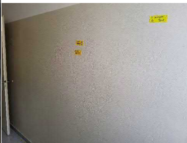
040-01 Standort: Erdgeschoss WC Damen
