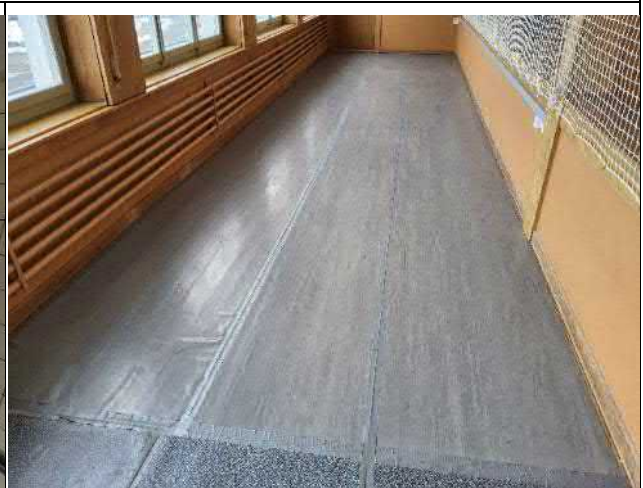
032-02 Standort: 1. Obergeschoss Galerie
