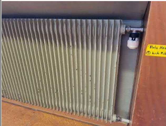
033-03 Standort: Erdgeschoss Turnhalle
