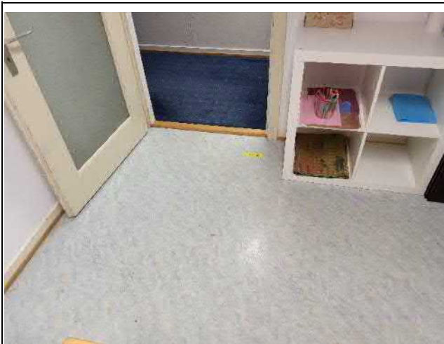
024-05 Standort: Dachgeschoss Raum 6
