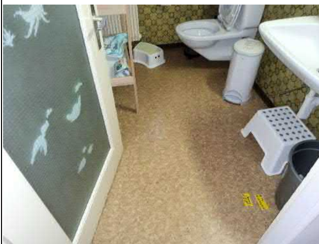
008-08 Standort: Dachgeschoss Raum 2 (Bad)
