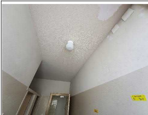
012-07 Standort: Erdgeschoss WC Damen
