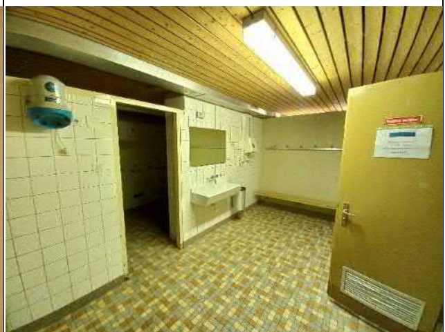
037-10 Standort: 1. Untergeschoss Umkleide-Raum Dusche
