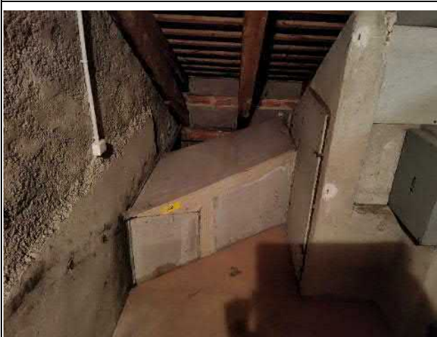
001-03 Standort: Dachgeschoss Estrich
