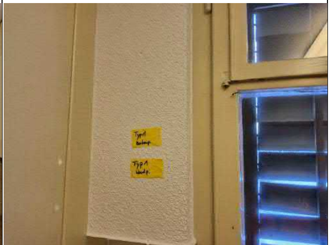
013-03 Standort: Dachgeschoss Raum 3 (Küche)
