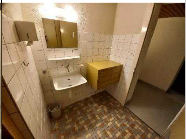
037-08 Standort: 1. Untergeschoss Einzel-Dusche 1
