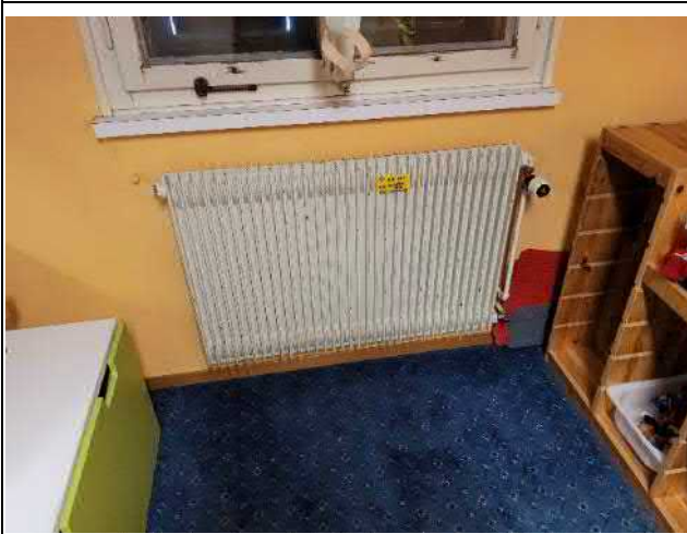
021-01 Standort: Dachgeschoss Raum 4/5
