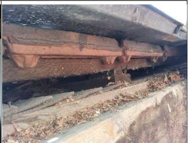
006-01 Standort: Dachgeschoss Estrich
