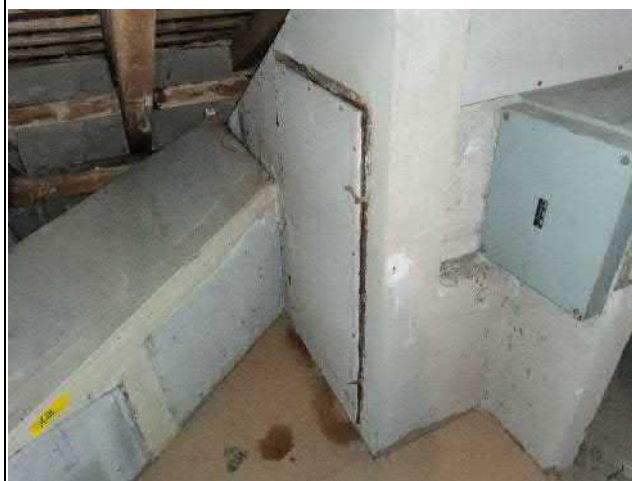
050-02 Standort: Dachgeschoss Estrich
