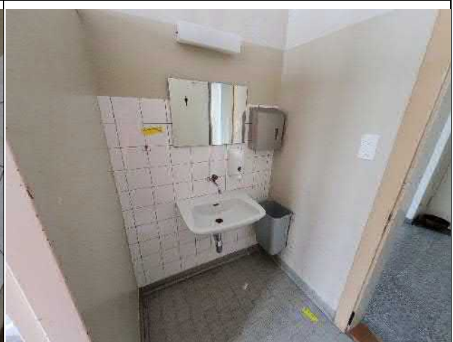
037-06 Standort: Erdgeschoss WC Herren
