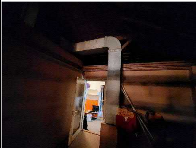
001-04 Standort: Dachgeschoss Estrich
