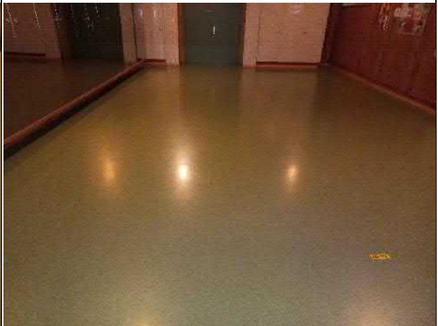
071-01 Standort: 1. Untergeschoss Laufbahn
