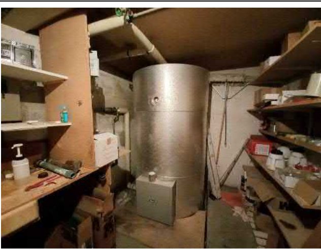
003-04 Standort: 1. Untergeschoss Putzmaterial
