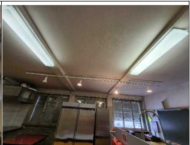
047-02 Standort: Erdgeschoss Küche
