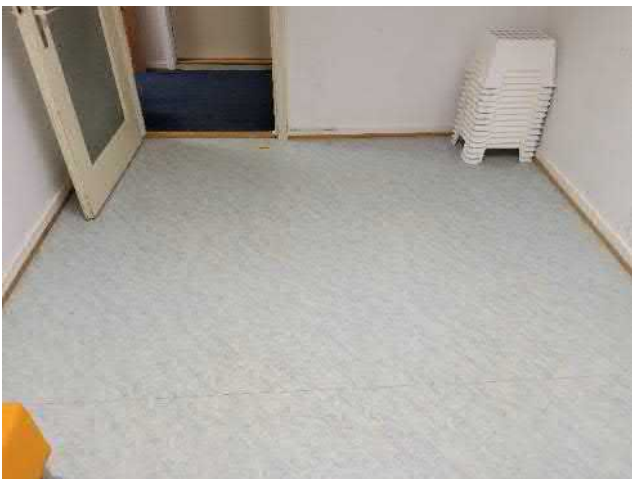
024-04 Standort: Dachgeschoss Raum 7
