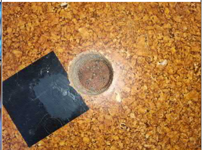
064-01 Standort: Erdgeschoss Turnhalle
