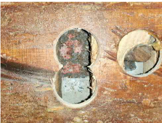
062-01 Standort: Erdgeschoss Turnhalle
