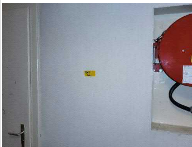
030-04 Standort: 1. Obergeschoss Gang
