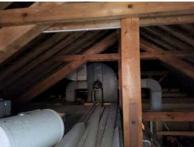
001-04 Standort: Dachgeschoss Estrich
