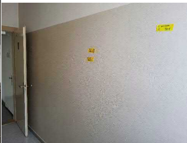
039-04 Standort: Erdgeschoss WC Damen
