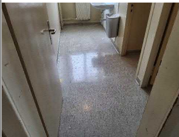
041-04 Standort: Erdgeschoss WC Damen
