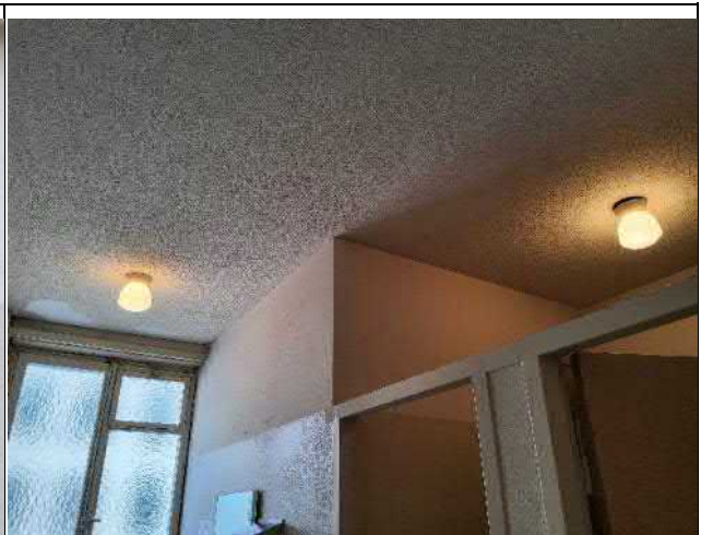
012-07 Standort: Erdgeschoss WC Damen
