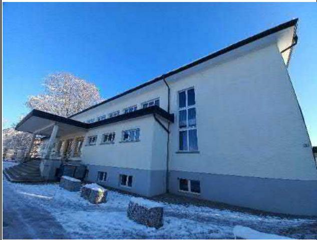
074-01 Standort: Erdgeschoss Aussenfassade
