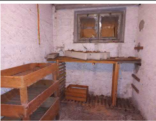
077-01 Standort: 1. Untergeschoss Keller
