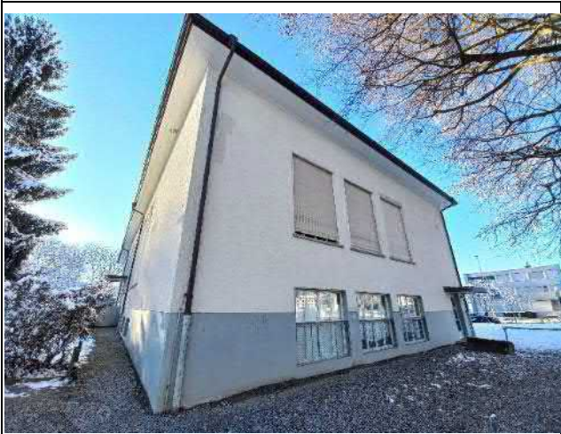
073-01 Standort: Erdgeschoss Aussenfassade
