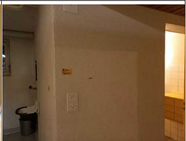
069-01 Standort: 1. Untergeschoss Korridor
