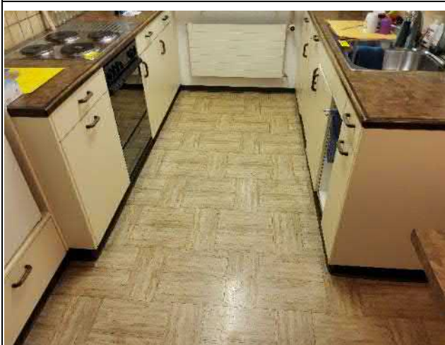
008-07 Standort: Dachgeschoss Raum 3 (Küche)
