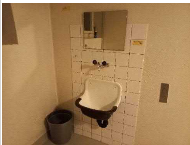
037-07 Standort: 1. Untergeschoss Korridor
