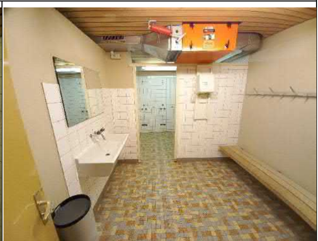
037-11 Standort: 1. Untergeschoss Umkleide-Raum Dusche
