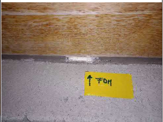
072-01 Standort: Erdgeschoss Aussenbereich
