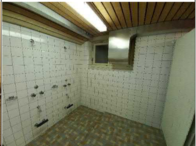
070-04 Standort: 1. Untergeschoss Umkleide-Raum Dusche
