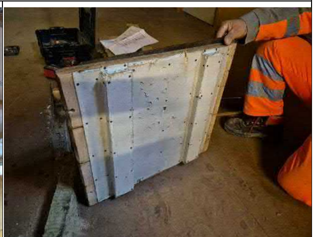
061-01 Standort: Erdgeschoss Turnhalle
