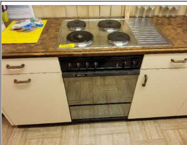
016-01 Standort: Dachgeschoss Raum 3 (Küche; Verdacht)
