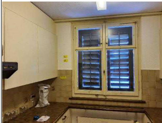
013-03 Standort: Dachgeschoss Raum 3 (Küche)
