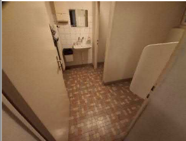
070-06 Standort: 1. Untergeschoss WC Männer
