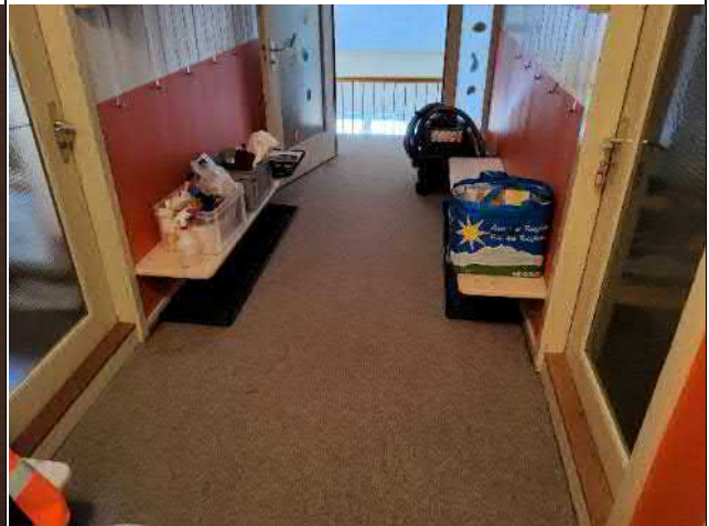
010-02 Standort: Dachgeschoss Korridor
