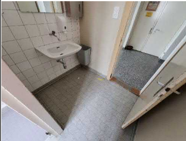
042-02 Standort: Erdgeschoss WC Herren
