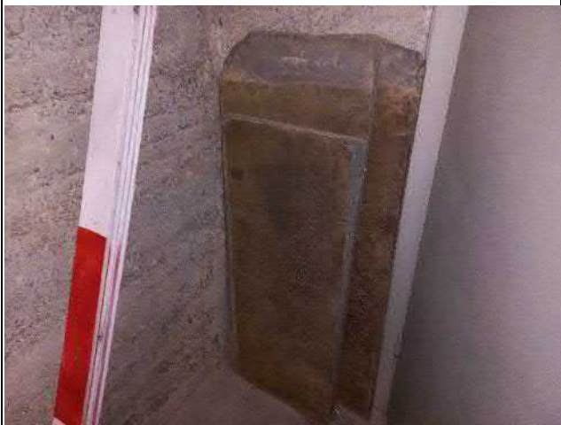
080-01 Standort: 1. Untergeschoss Werkstatt
