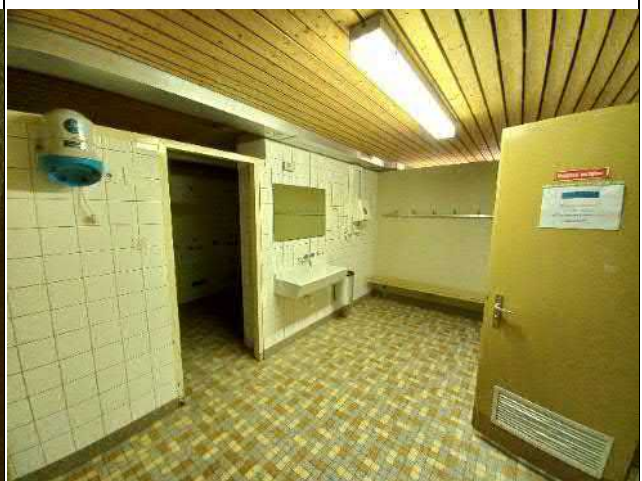
070-07 Standort: 1. Untergeschoss Umkleide-Raum Dusche
