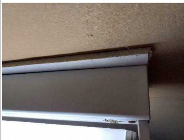
061-02 Standort: 1. Untergeschoss Abstellraum 1
