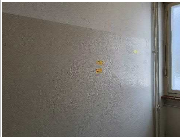
038-03 Standort: Erdgeschoss WC Damen
