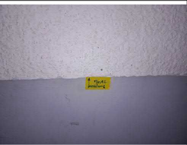
073-01 Standort: Erdgeschoss Aussenfassade
