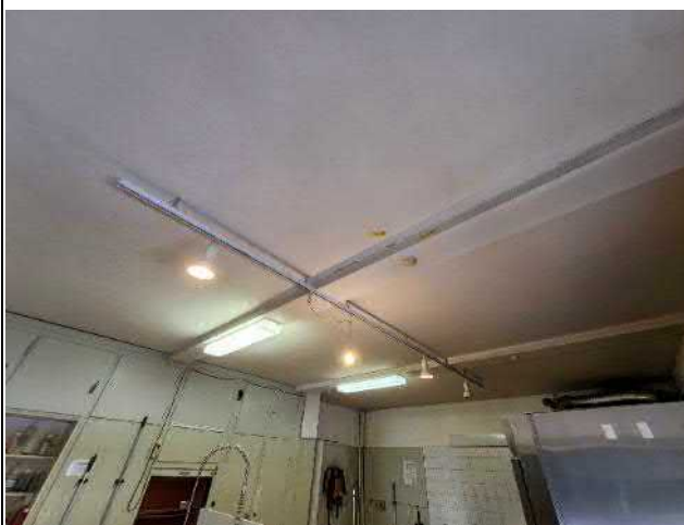
046-02 Standort: Erdgeschoss Küche
