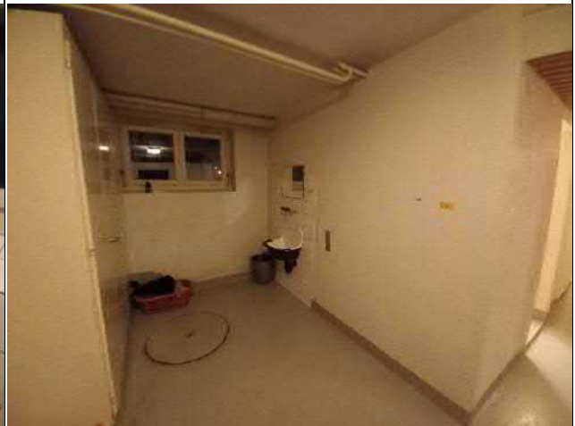
037-07 Standort: 1. Untergeschoss Korridor
