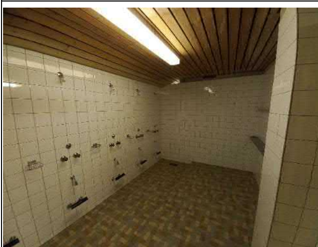
070-07 Standort: 1. Untergeschoss Umkleide-Raum Dusche
