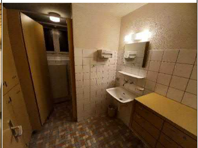
070-01 Standort: 1. Untergeschoss Einzel-Dusche 1
