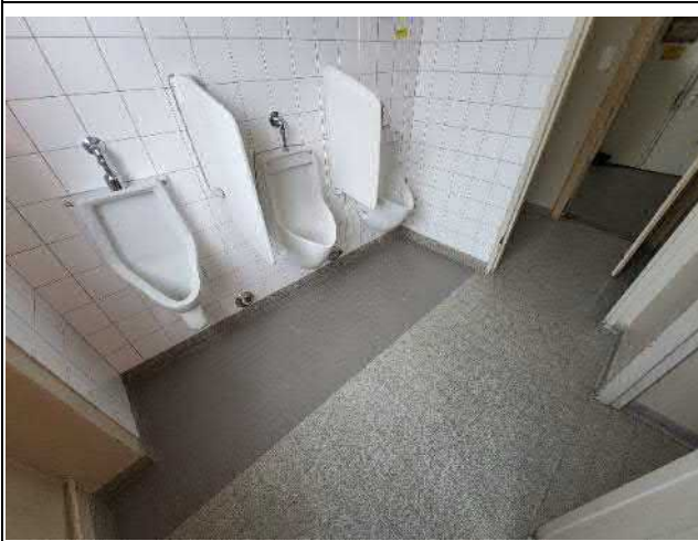
042-02 Standort: Erdgeschoss WC Herren
