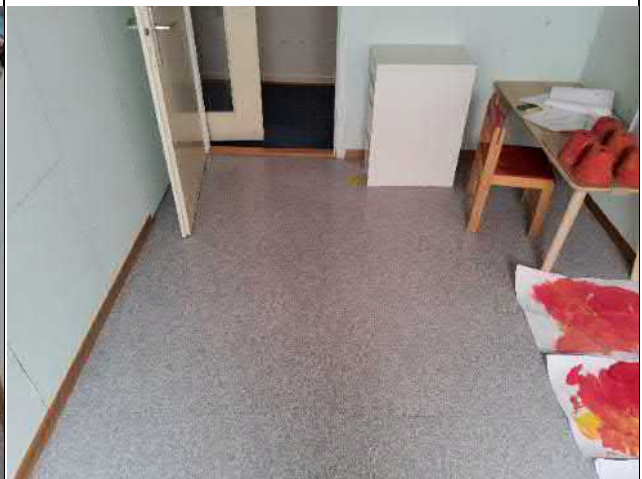
008-10 Standort: Dachgeschoss Raum 1
