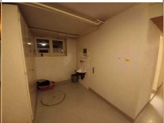
013-04 Standort: 1. Untergeschoss Korridor
