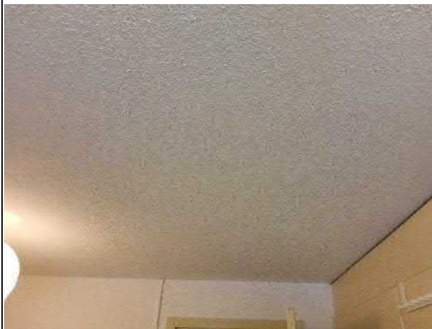
012-05 Standort: Dachgeschoss Raum 3 (Küche)
