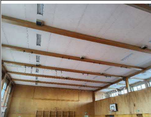
061-01 Standort: Erdgeschoss Turnhalle
