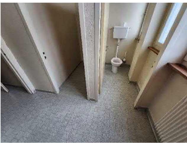
042-02 Standort: Erdgeschoss WC Herren
