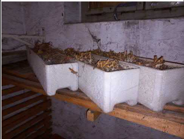
077-01 Standort: 1. Untergeschoss Keller
