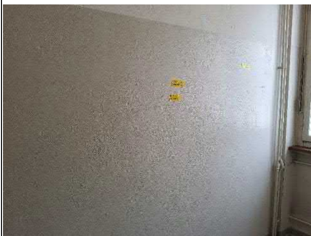
039-04 Standort: Erdgeschoss WC Damen
