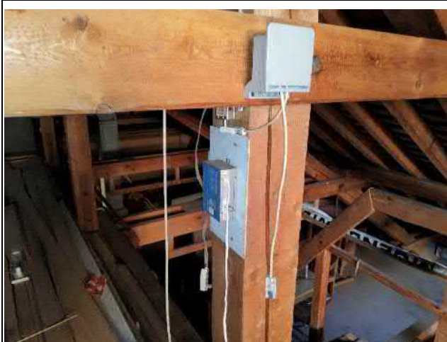
004-01 Standort: Dachgeschoss Estrich
