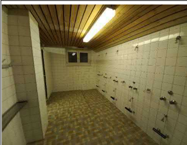
037-10 Standort: 1. Untergeschoss Umkleide-Raum Dusche
