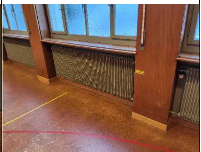
033-03 Standort: Erdgeschoss Turnhalle
