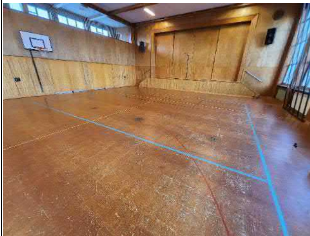
064-01 Standort: Erdgeschoss Turnhalle
