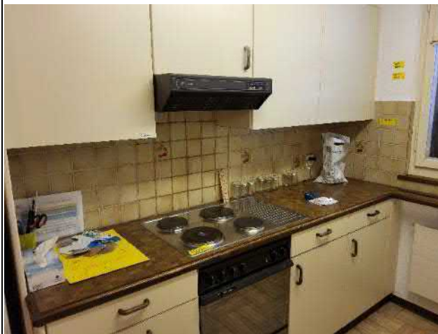
014-05 Standort: Dachgeschoss Raum 3 (Küche)
