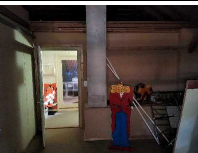
001-04 Standort: Dachgeschoss Estrich
