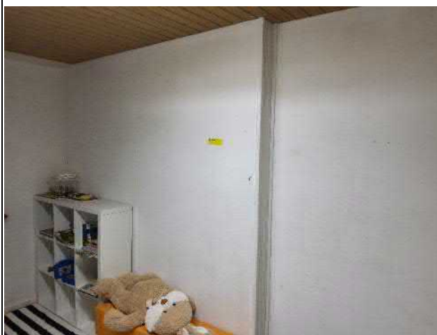
023-03 Standort: Dachgeschoss Raum 7
