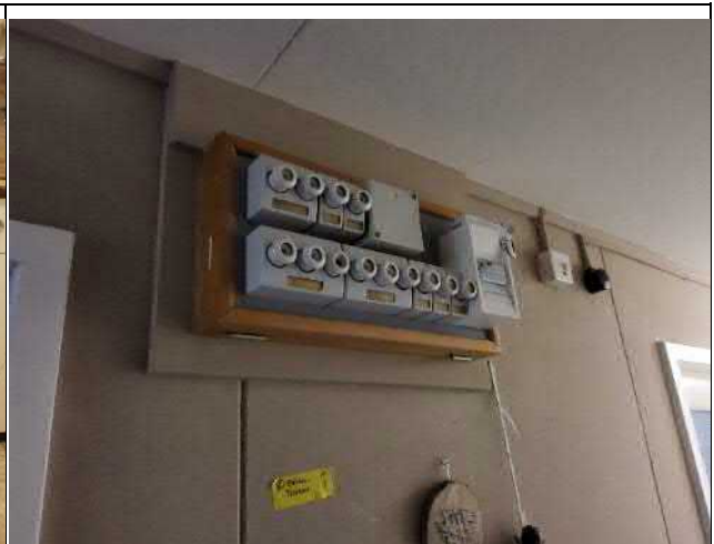
018-01 Standort: Dachgeschoss Korridor
