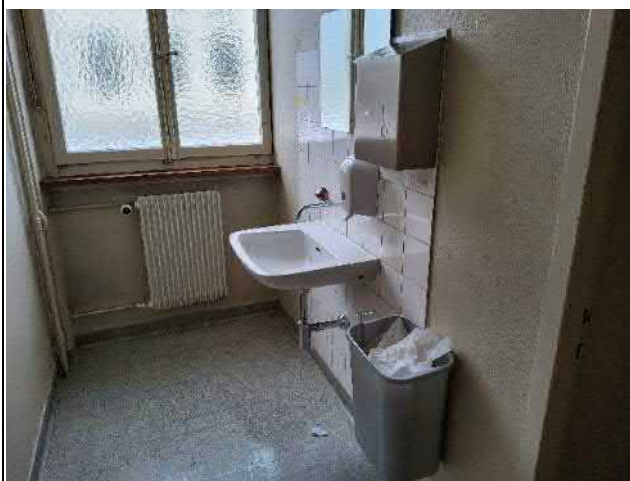
037-05 Standort: Erdgeschoss WC Damen
