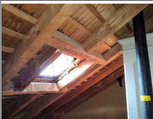
006-01 Standort: Dachgeschoss Estrich
