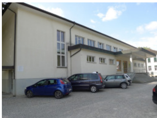
Ansicht der Nordfassade von Nordwesten.
