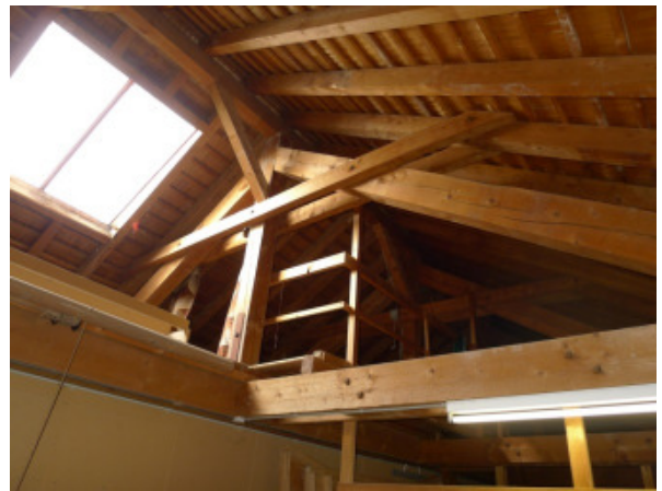
Ansicht des Dachwerks von 1939/40.
