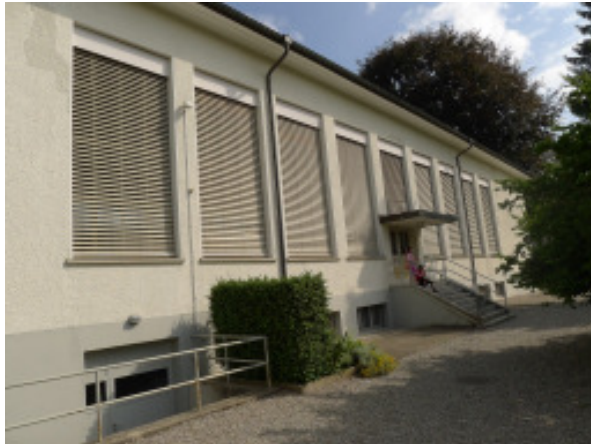
Ansicht der Südfassade von Osten.
