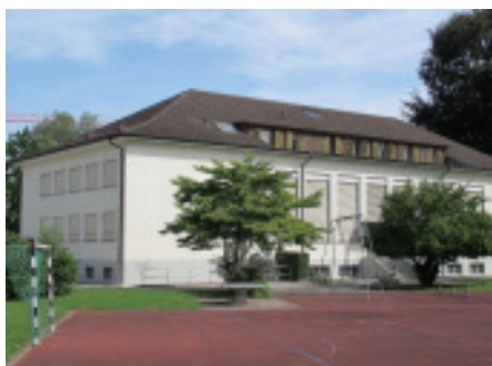
Ansicht der Turnhalle von Süden mit der südlichen Dachfläche.
