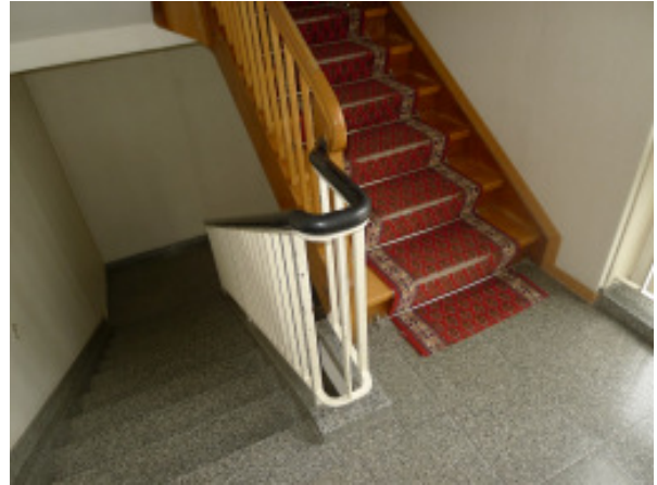
Detail des Treppenhauses mit Treppen von 1939/40.
