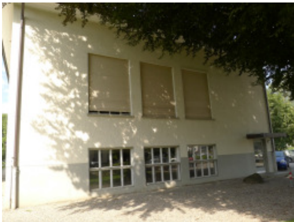
Ansicht der Ostfassade.
