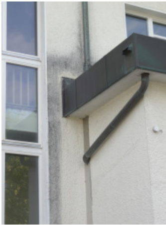
Detail des 1983 renovierten Dachs über dem Gebäudevorsprung im Erdgeschoss.
