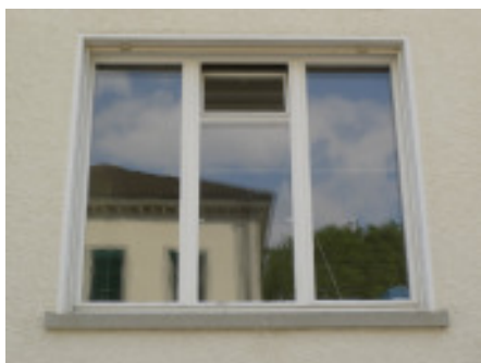
Westfassade, Detail eines Fensters im Hochparterre.
