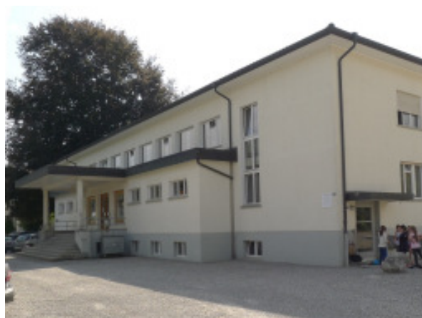
Ansicht der Nordfassade von Nordosten.
