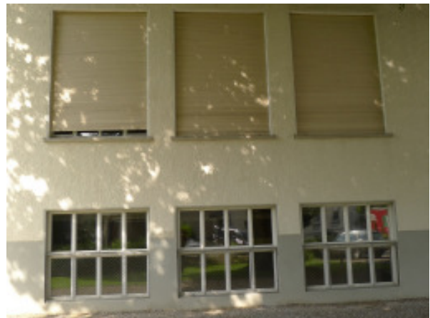
Ostfassade, Detailansicht der Fenster.
