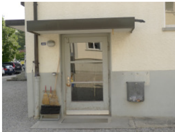
Westfassade, Detail der Eingangstür.
