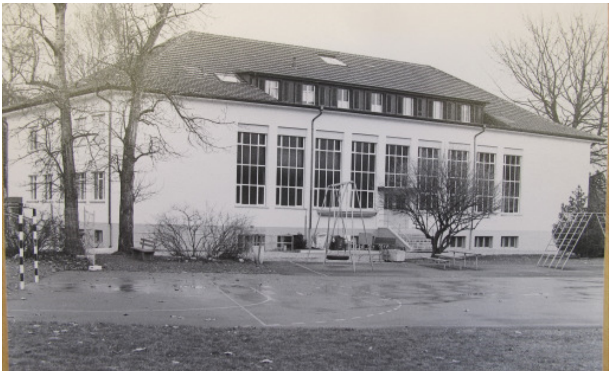
Ansicht der Turn- und Mehrzweckhalle von Südosten. Nach 1975.
