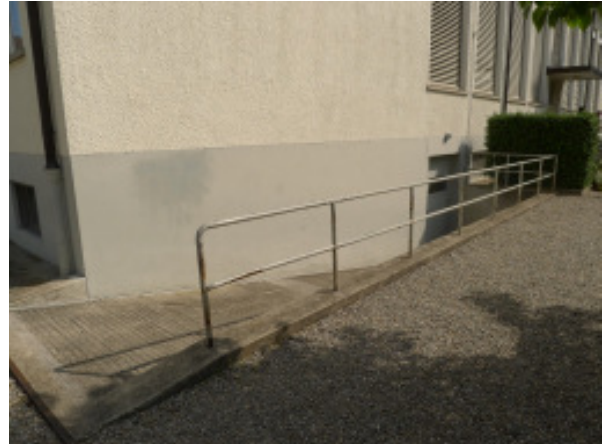
Südfassade, Ansicht des Kellerabgangs.
