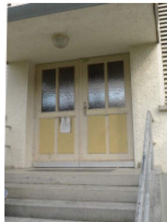
Südfassade, Detail der bauzeitlich erhaltenen Eingangstür.
