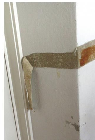
Sichtbar bröckeln überall Wände und Decken. Risse durchziehen gewisse Mauern und die Tapeten lösen sich.
